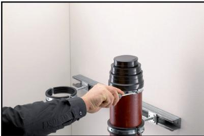
1. Schuif het open uiteinde van de OHA-Multi-Connector over het uiteinde van de leiding en plaats de slangklem in de daarvoor bestemde uitsparing. Draai vervolgens de slangklem stevig vast terwijl u de positie handhaft.
