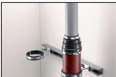
3. Oznaczyć rurę łączącą na głębokość wsunięcia, nasmarować, wsunąć i zamocować za pomocą pozostałych opasek zaciskowych.
