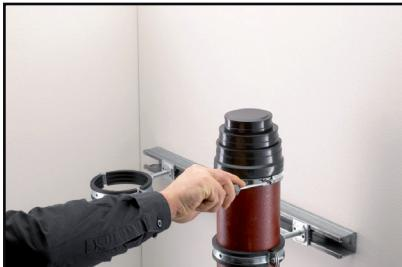
1. Deslice el extremo abierto del conector múltiple OHA sobre el extremo de la tubería y coloque la abrazadera de la manguera en el hueco previsto. A continuación, apriete firmemente la abrazadera de la manguera manteniendo su posición.
