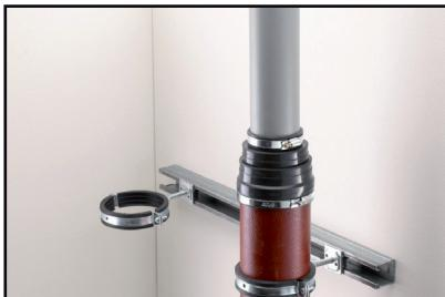
3. Marquez le tube de raccordement à la profondeur d'insertion, appliquez du lubrifiant et enfoncez-le et fixez-le avec les autres colliers de serrage.
