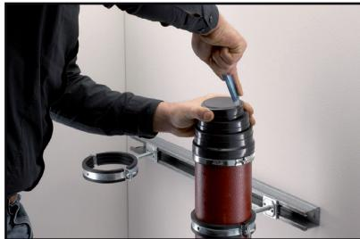
2. Retirez les évidements en fonction de la taille requise du tube utilisé.
