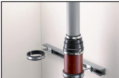
3. Jelölje meg a csatlakozócsövet a beillesztési mélységben, kenje meg, tolja be és rögzítse a többi tömlőbilincsel.
