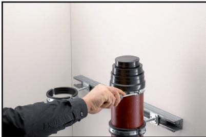
1. Faites glisser l'extrémité ouverte du connecteur multiple OHA sur l'extrémité du tuyau et placez le collier de serrage dans l'évidement prévu à cet effet. Ensuite, serrez fermement le collier de serrage tout en maintenant sa position.
